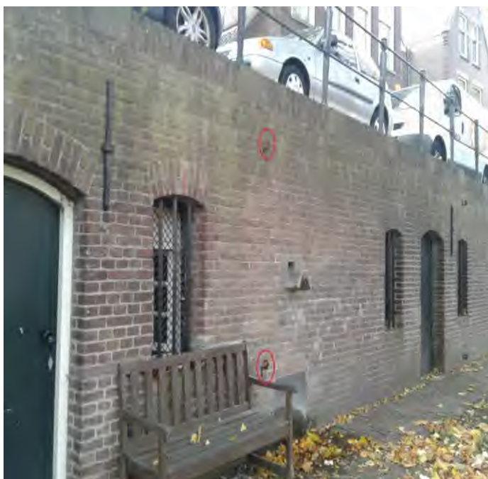
Figuur 4: Voorbeeldfoto positie prisma's (rood omcirkeld)
